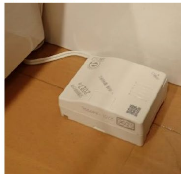
ガス警報器の不適切な設置例
