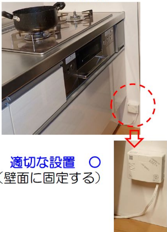
ガス警報器の 適切な設置例
