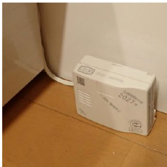
ガス警報器の不適切な設置例
